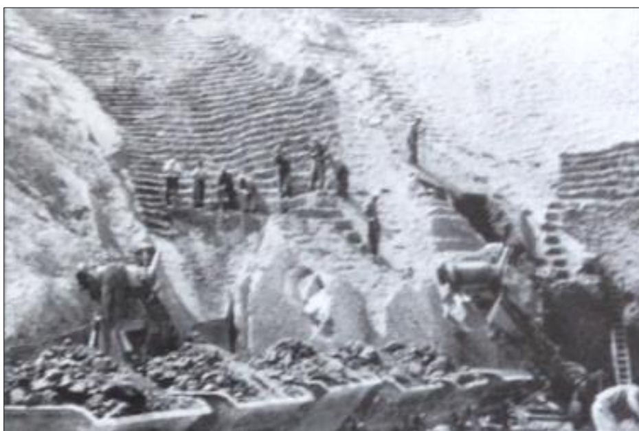
På billedet ses "trapperne" samt tipvognen, som man transporterede moleret i. Foto: Fur Museum
